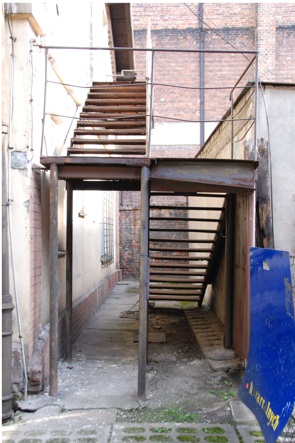
Fot. 4. Stalowa klatka schodowa (4) przylegająca do południowej elewacji budynku „C”
